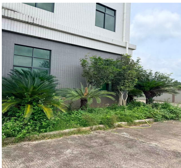
图3-1 地埋式三级化粪池
