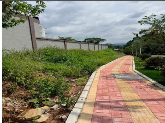
厂区外管道铺设
