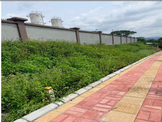
厂区外管道铺设
