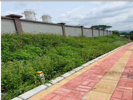
厂区外管道铺设
