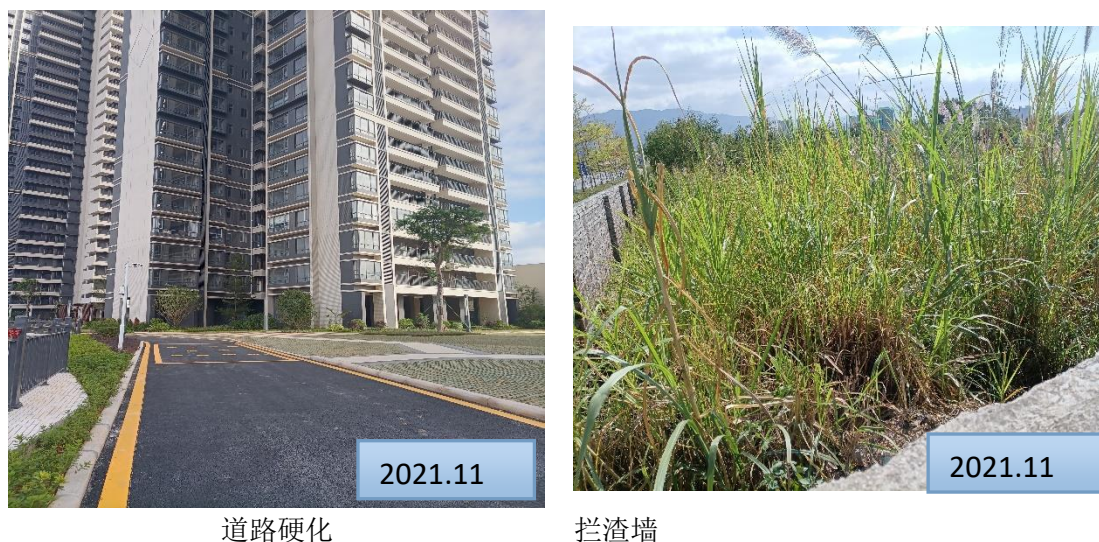
图 4-1 水土保持工程措施现状
