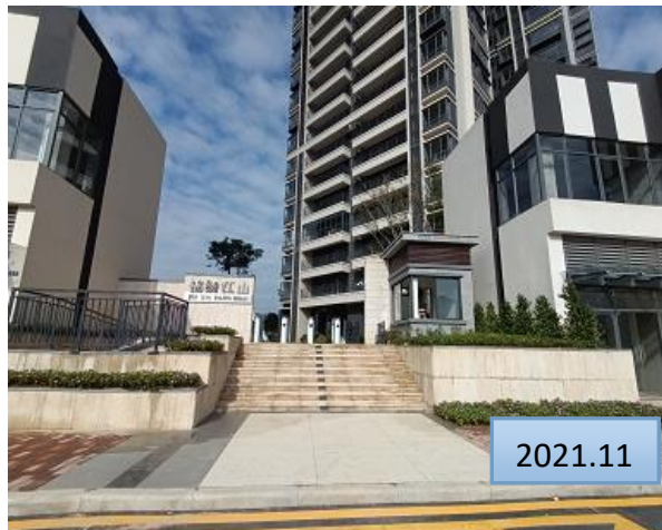
现状硬化道路及绿化
