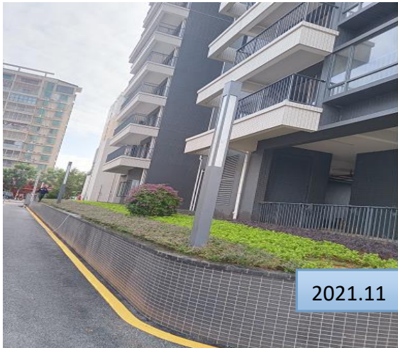
现状硬化道路及绿化
