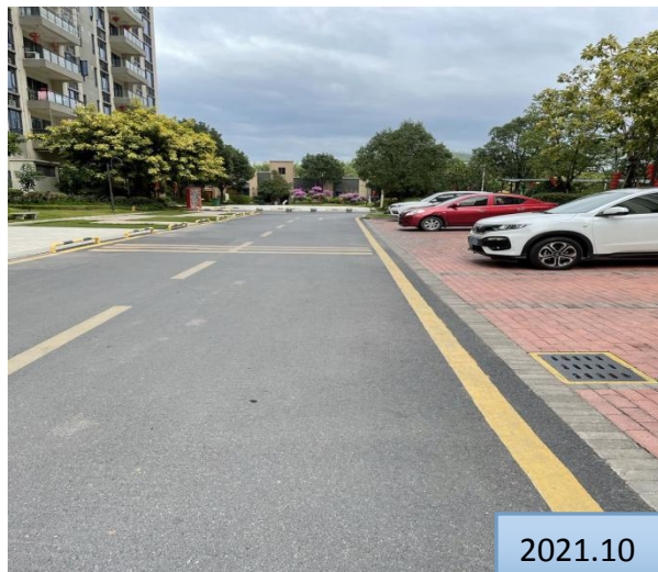
已完成的硬质铺地及雨水篦
