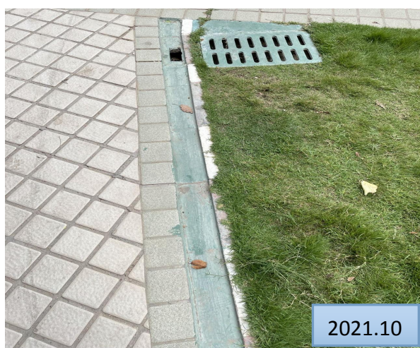
已完成的排水沟及雨水篦
