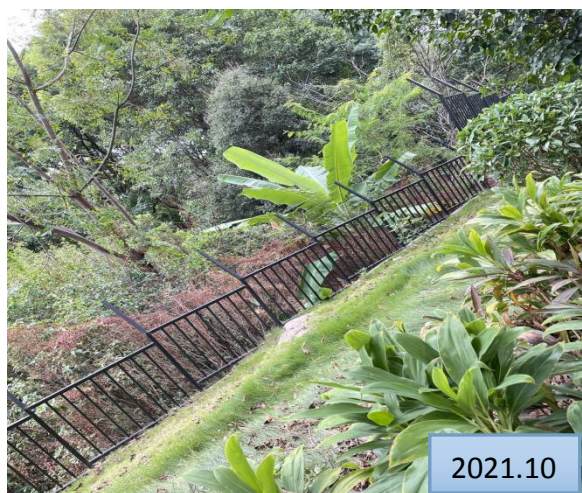
已完成的边坡绿化
