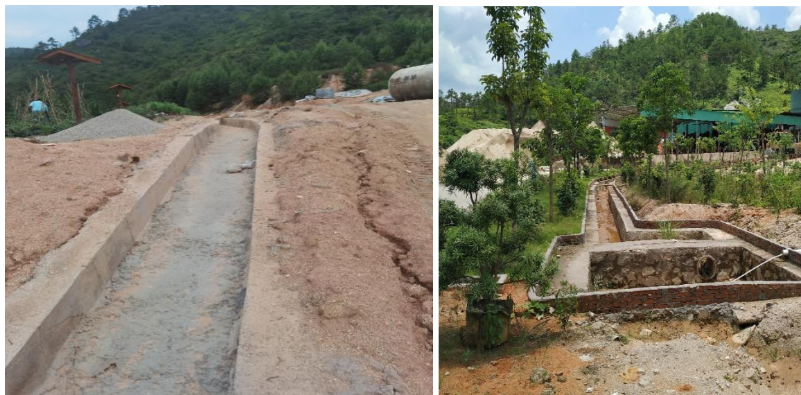
图 3-1 水土保持工程措施照片
