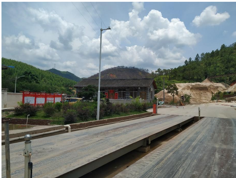
办公生活区现状
