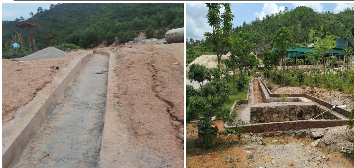
图 4-1 水土保持工程措施现状照片
