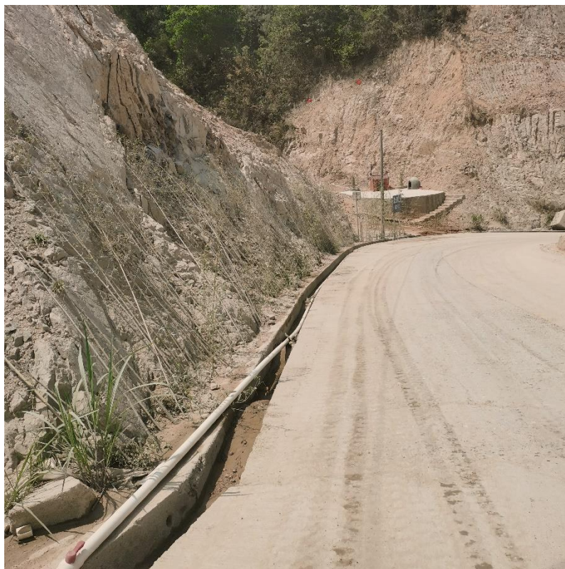
矿山道路排水沟
