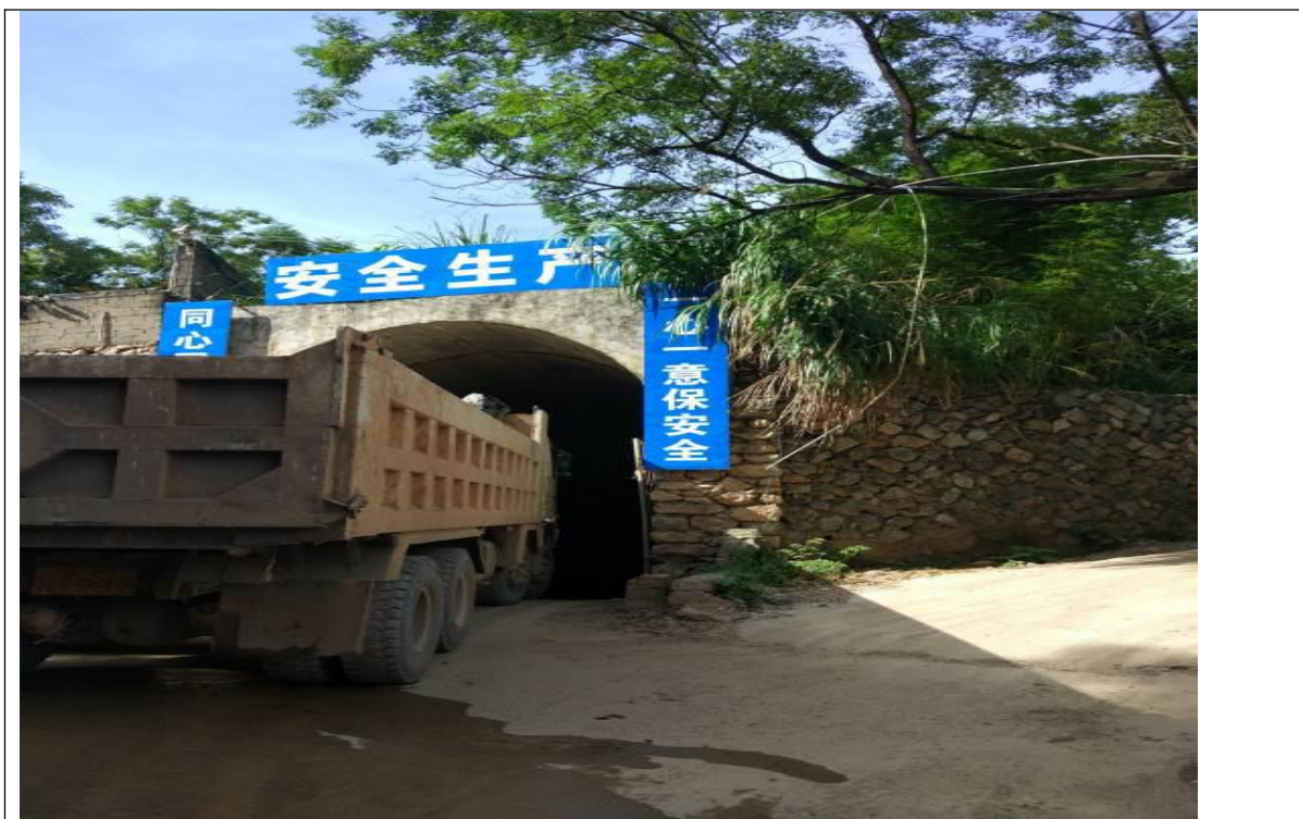
采矿硐口现状
