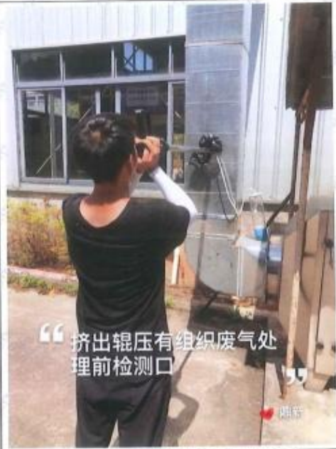
挤出辊压有组织废气排放处理前检测口
