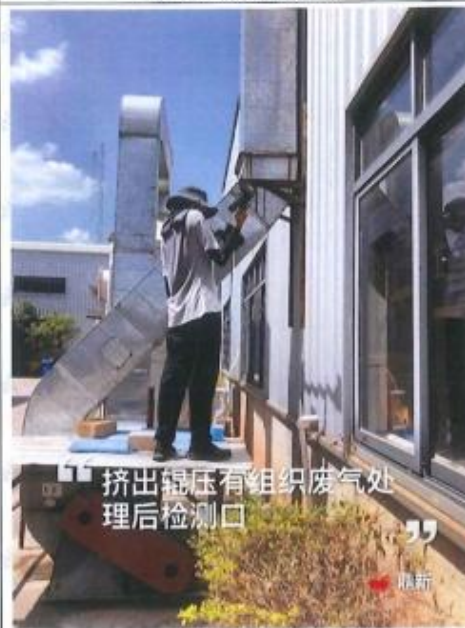
挤出辊压有组织废气排放处理后检测口
