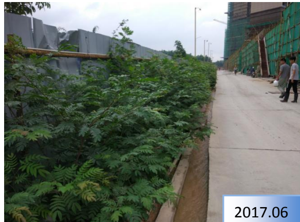
施工道路及排水沟
