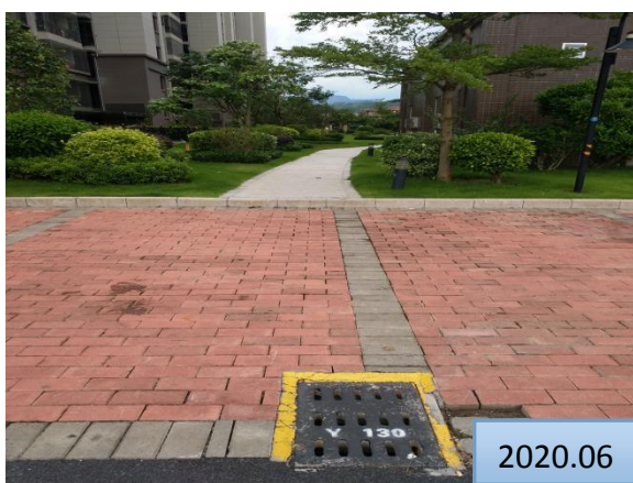
已完成的硬质铺地及雨水篦
