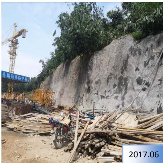
材料堆放场地，开挖边坡
