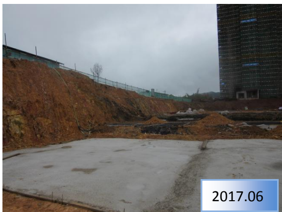
施工过程中开挖边坡
