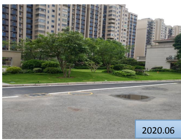
已完成的硬质铺地及雨水篦
